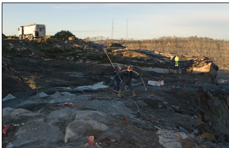
Figur 4.7. Laddning av salva med bulksprängmedel
