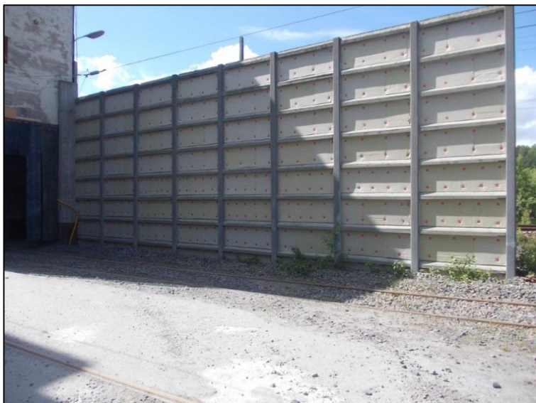
Figur 4.13. Bullervägg vid järnvägslastning
