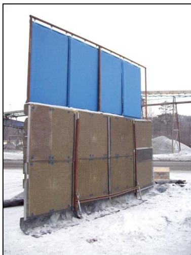
Figur 4.6. Exempel på flyttbar bullerskärm
