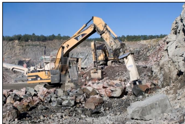
Figur 4.8. Sönderdelning med hydraulhammare
