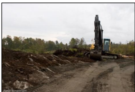
Figur 4.2. Avbaning med grävmaskin
