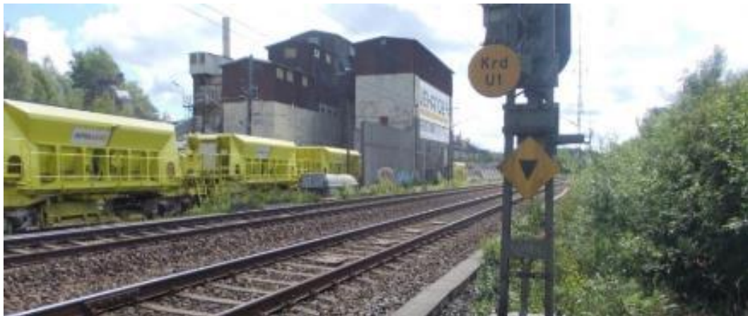
Figur 38. Kålleredstäktens tåglastningsstation, vy mot sydost.
