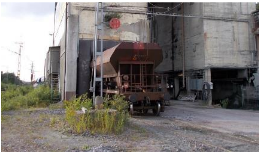
Figur 40. Södra öppningen. Bullerdämpande åtgärder: Ljuddämpande gummimattor i öppningen.
