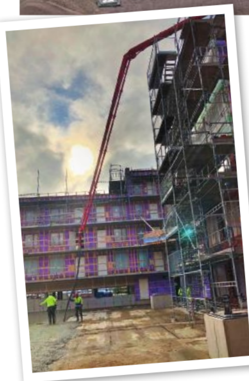
Den stora vinsten med Swerocks nya betongpump är att man når högt för gjutning på nivåer man tidigare inte nått. Eller som här där Per gått över en huskropp för gjutning på en innergård.
