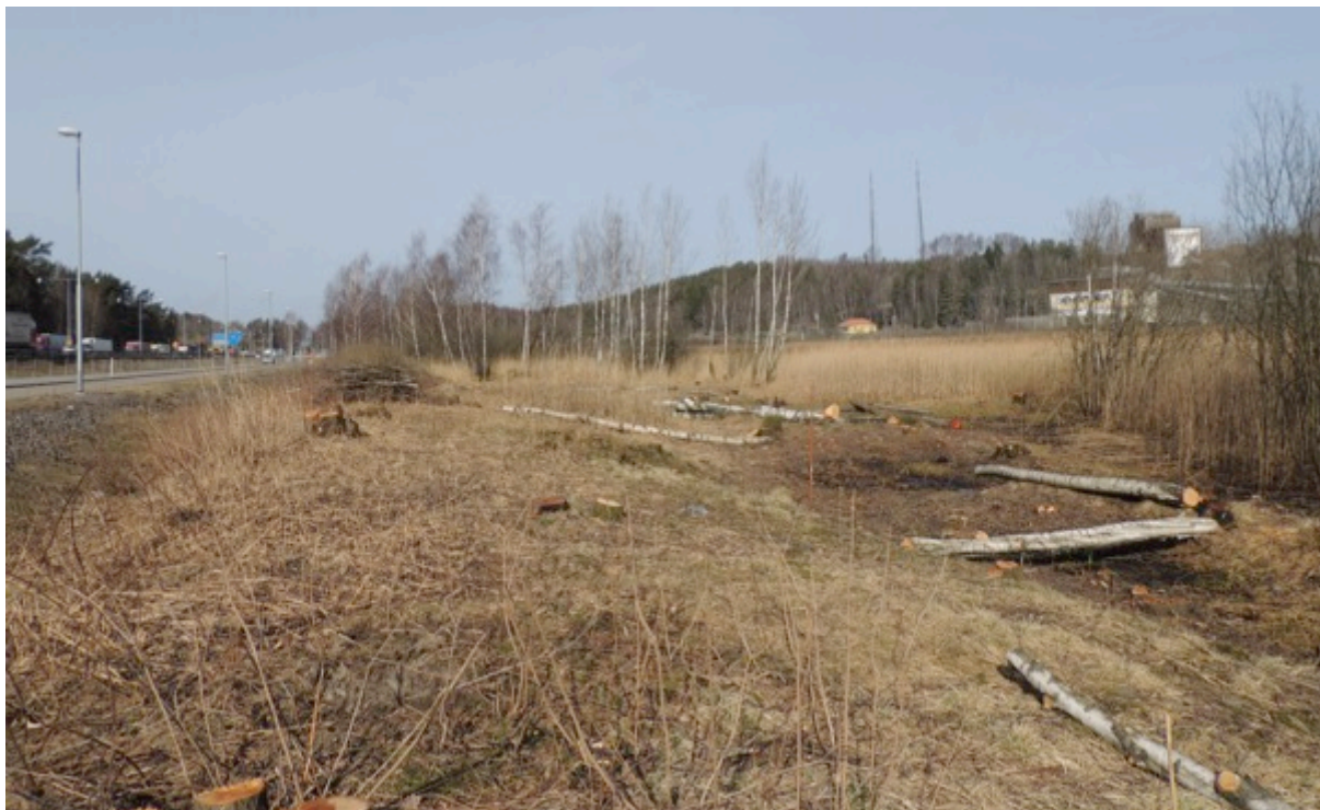
Bild 20. Västra sidan, pågående arbete med röjning mars 2014.
