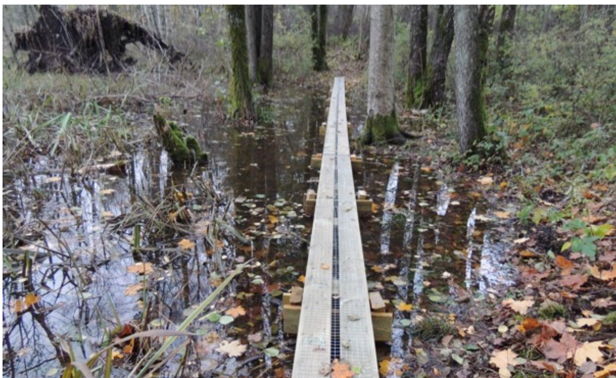
Bild 4. Delar av stigen på västra sidan har anlagts med spångar för att man ska kunna gå torrskodd även när vattennivån stiger. Fotograferad oktober 2014.
